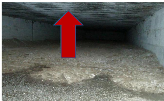
Abbildung 4 - Unterflurkanal mit losen Schmutzpartikeln und CIPC-Rückständen
