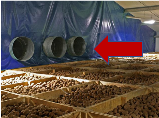
Abbildung 5&6 Belüftungs- und Kühltechnik mit Luftverteilereinrichtung im Kistenlager
